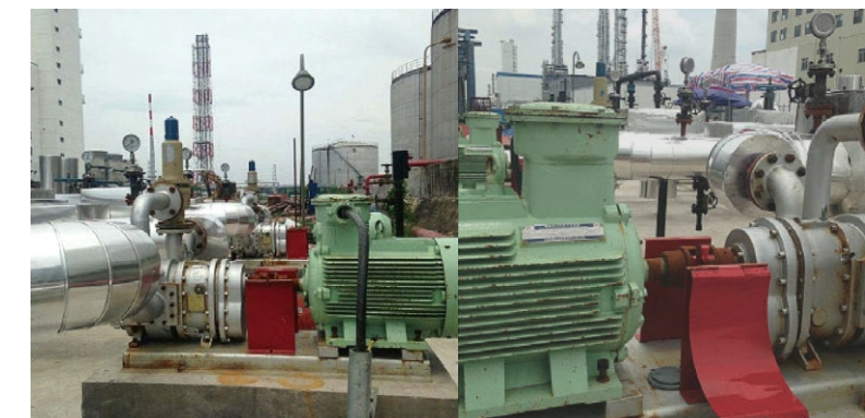
转子泵在沥青输送现场
