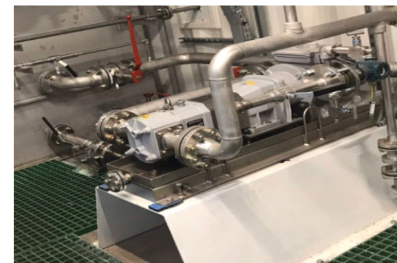
金属转子泵在DMSO项目现场
