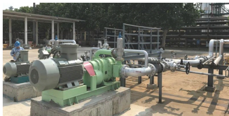
转子泵佩带篮式过滤器、安全阀在化工行业现场
