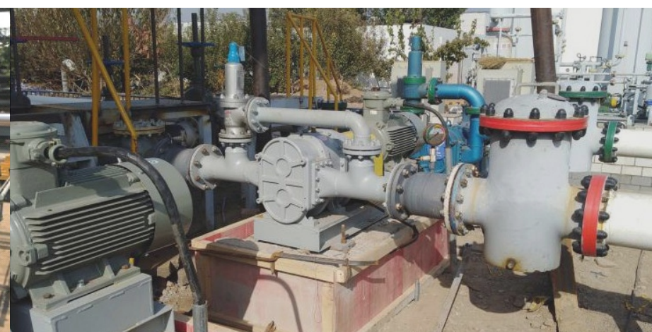
转子泵佩带篮式过滤器、安全阀在化工行业现场
